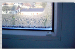
Kondenzat v robnem območju notranje šipe ni neobičajen tudi pri sodobni zasteklitvi
